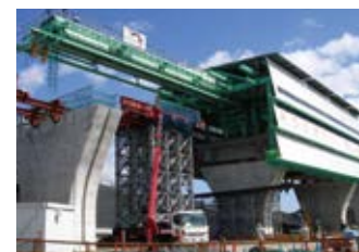
大型移動支保工架設工法
