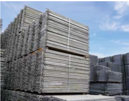
整備完成布板材ヤード
