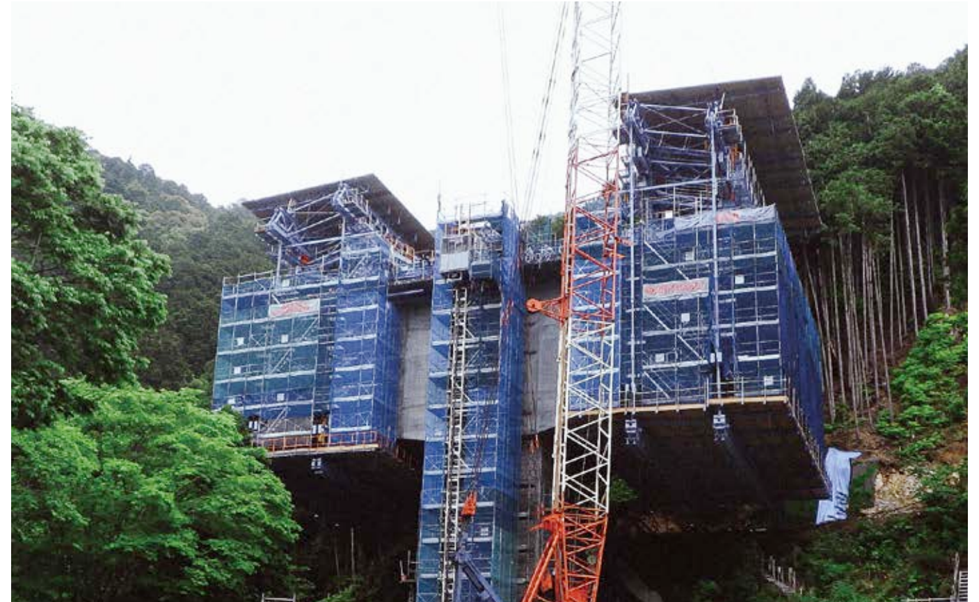
片持架設工法
