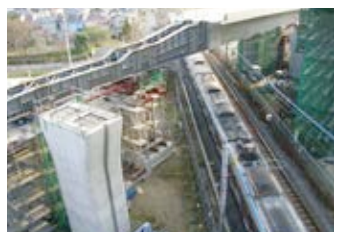
押し出し架設工法
