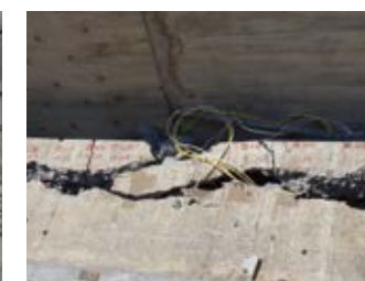
放電破砕工法
